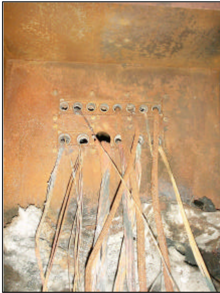
Figuur 5: Foto's van de kabeldoorvoeringen na de brand. De openingen tonen aan dat de kabeldoorvoeringen niet brandwerend uitgevoerd waren (Bron: Onderzoeksraad).
